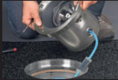
Die patentierte Leuchtenkonstruktion aus Edelstahl und Edelstahlguss zeichnet sich durch eine besonders hohe Druckbelastbarkeit aus und ist für Bereiche höchster Beanspruchung geeignet – BEGA Patent EP 2 418 419.
