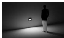
asymmetrisch-bandförmige Lichtstärkeverteilung
