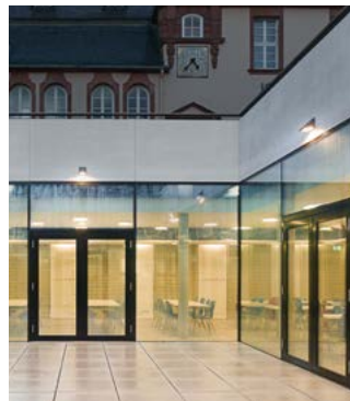
Die Leuchten können mit dem Lichtaustritt nach oben oder unten montiert werden.
