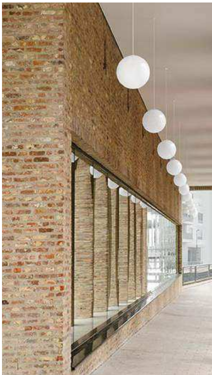
Pendelleuchten in Sonderanfertigung mit weißem Leitungspendel und ohne Montagedose
