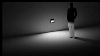
asymmetrisch-bandförmige Lichtstärkeverteilung
