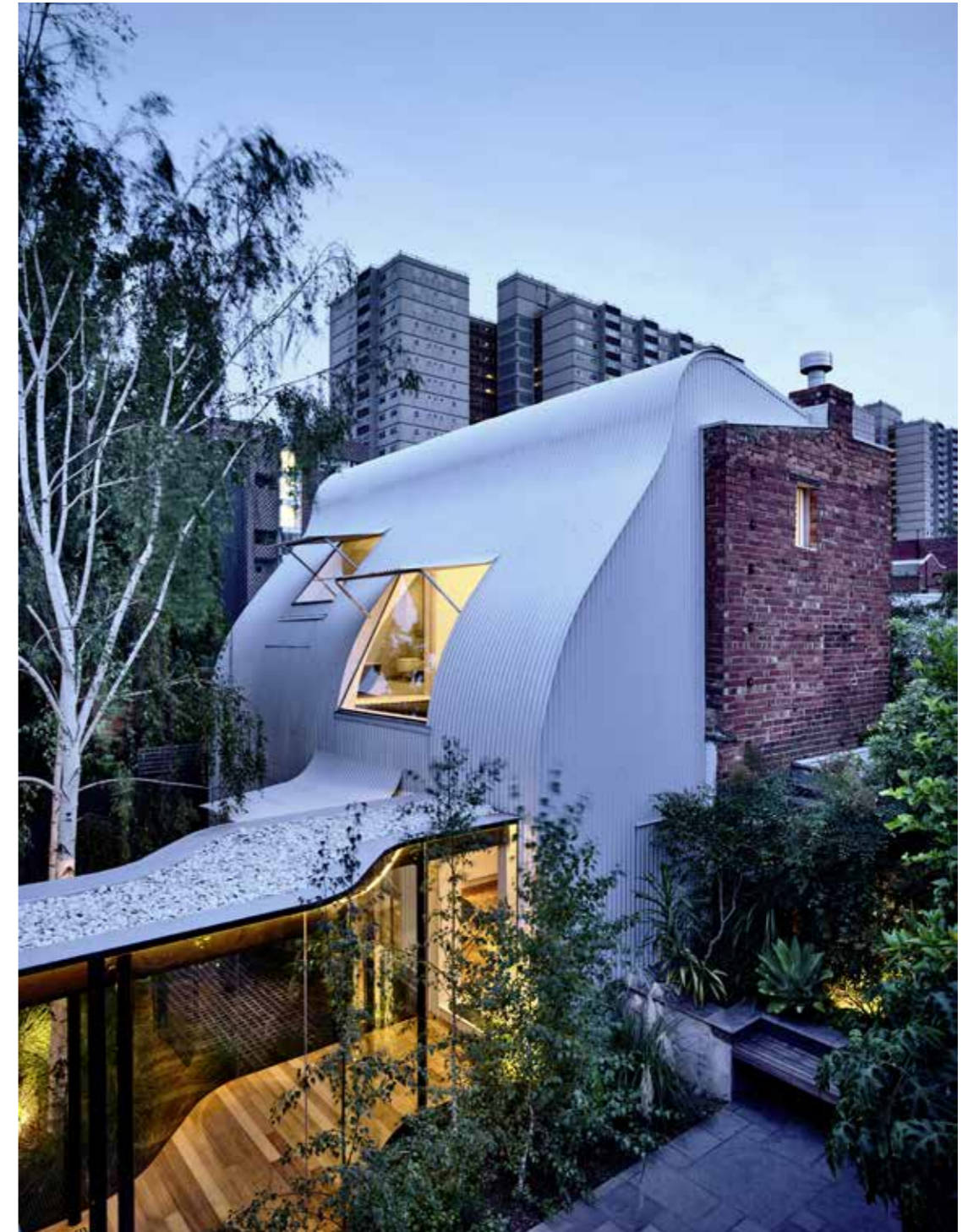
Vom vernachlässigten Hinterhof zum echten Hingucker: „King Bill“ im australischen Melbourne. From neglected back yard to genuine eye-catcher: “King Bill” in Melbourne. (Austin Maynard Architects)
